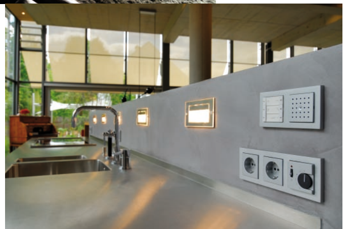
In die halbhohe Trennwand der Küche wurde ein Unterputzradio passend zur Schalterserie eingebaut.
