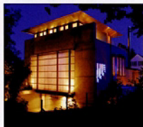
Ganz anders die Fassadengestaltung zur Straßenseite hin: Hier steht eine massive Fläche aus Sichtbeton, durchbrochen nur von einer streng gegliederten Fensterfläche.
