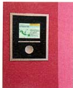
Die Gebäudetechnik wird mit Hilfe eines Bussystems (KNX/EIB) gesteuert. Licht, Fenster, Verschattung, Alarm und Heizung können so bequem gesteuert und überwacht werden, dezentral über Tastsensoren (unten rechts) oder zentral über das Terminal mit Display (unten links).
