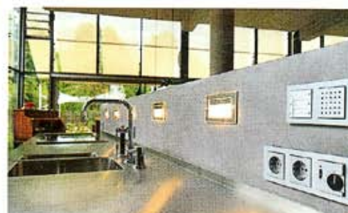
Die Gebäudetechnik wird mit Hilfe eines Bussystems (KNX/EIB) gesteuert. Licht, Fenster, Verschattung, Alarm und Heizung können so bequem gesteuert und überwacht werden, dezentral über Tastsensoren (unten rechts) oder zentral über das Terminal mit Display (unten links).
